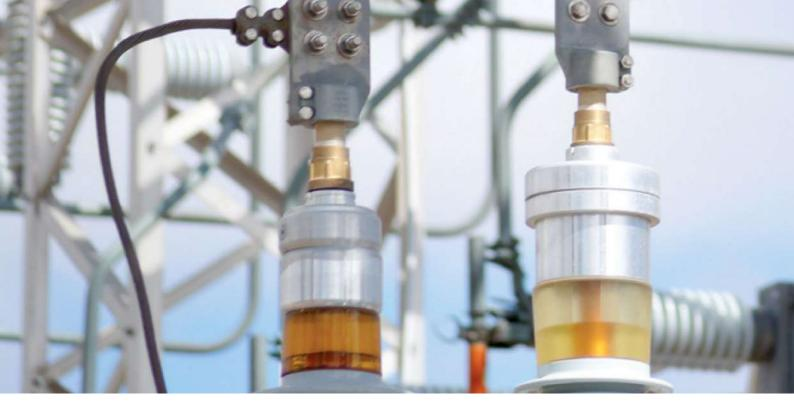
Les analyses d'huile de transformateur vous offrent une idée précise de l'état de votre transformateur et du fluide isolant. La détection anticipée des variations des caractéristiques chimiques ou de la contamination au sein du fluide isolant permet d'être averti très tôt des problèmes potentiels, évitant ainsi un temps d'arrêt indésirable et une maintenance imprévue coûteuse.
