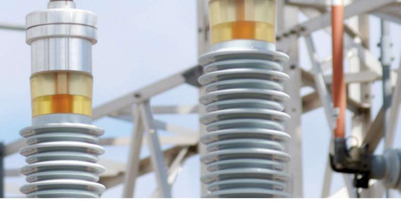
elle cause des problèmes avec l'isolant papier, et est attirée dans des zones de contrainte électrique entraînant une corrosion. La décomposition de l'isolant papier est irréversible et réduit significativement la durée de vie du transformateur. L'origine de l'eau est soit atmosphérique (fuites), soit interne (provenant de l'isolation papier).
